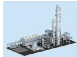
CO<sub>2</sub>分離回収実証設備イメージ図
