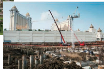
第2期工事の状況(2013年2月時点)
