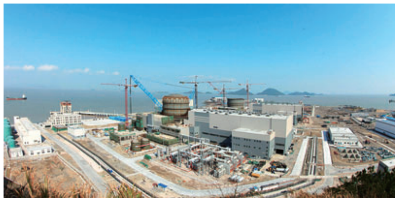
中国浙江省三門原子力発電所
