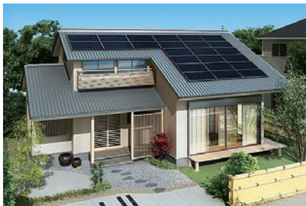
住宅用太陽光発電システム
