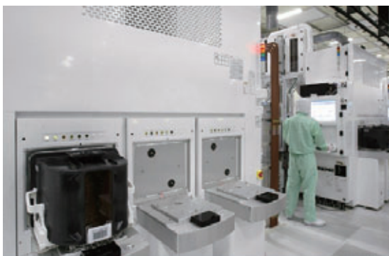
四日市工場 第5製造棟 (クリーンルーム)
