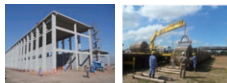
東芝社会インフラシステム南米社 既受注案件建設状況
