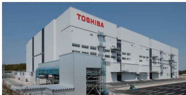
四日市工場の第5製造棟が竣工 2011年7月から生産開始
