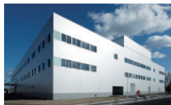
2009年5月に稼働開始 した新開発棟
