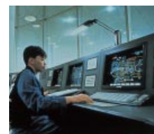
ビール会社向け監視制御システムでは、PCとPLC(Programmable Logic Controller)でオープンかつライトサイジングなシステムを実現し、基幹系システムとの親和性の向上により、リアルタイムでの進捗管理を可能にしました。
