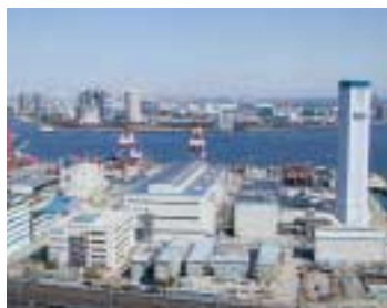
東京電力(株)品川火力1号系列1140MW発電設備を主契約者として受注し、現在建設を進めています。これは1300級ガスタービン採用のコンバインドサイクル発電で、2001年7月初軸運転開始予定です。
