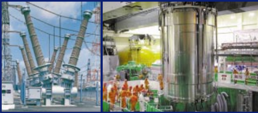
東京電力(株) 福島第一原子力発電所第三号機向け世界初の炉心シュラウドの取り替え風景
