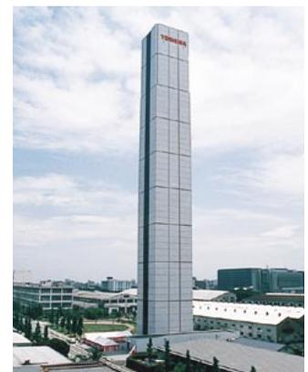
当社の府中工場内に設置された150m級の超高速エレベータ研究塔。ここでは、大深度地下構造物向けなどの超高速エレベータから、需要増が期待できる東南アジアに密着した機種の開発も手掛けています。
