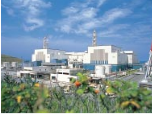
数々の新技术を採用したABWRの第1号機 柏崎刈羽6号機が稼働しました。
