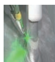
レーザーピーニングによる応力改善 Residual Stress Improvement by Laser Peening
