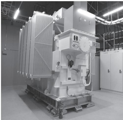
図5. TAKANAWA GATEWAY CITY特高電気室納入菜種油入変圧器
