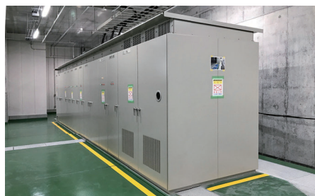
電力システムに適用した 24 kV 固体絶縁スイッチギア 24 kV solid insulated switchgear
