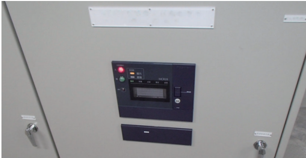
複合型保護継電器を実装したスイッチギヤ Switchgear with composite protective relay
