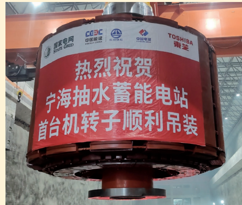
回転子のつり込み Rotor installation
