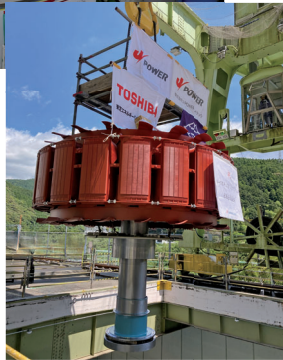
回転子のつり込み Installation of generator rotor
