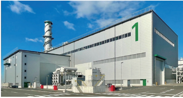
1号タービン・電気制御建屋 Goi Thermal Power Station Unit 1 turbine and control building
