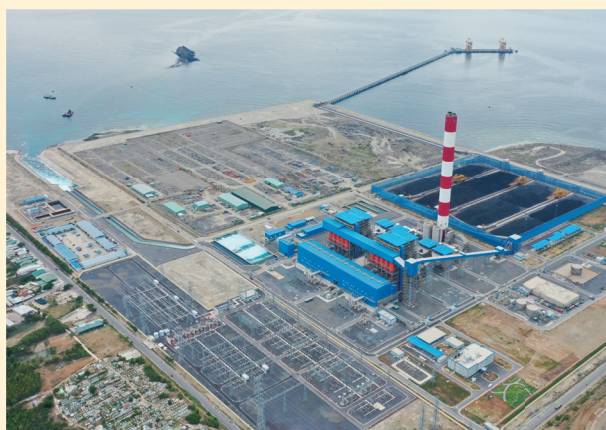
ベトナム バンフォン1発電所1, 2号機 Van Phong Thermal Power Plant Units 1 and 2, Vietnam
