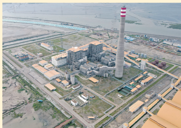
バングラデシュ マタバリ発電所1, 2号機 Matarbari Power Plant Units 1 and 2, Bangladesh
