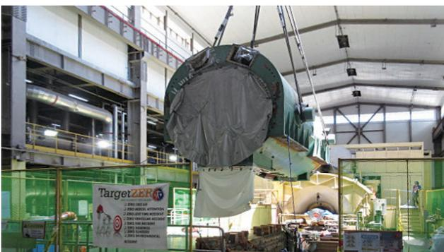
固定子コイル巻き替え後の旧発電機固定子のつり込み作業
