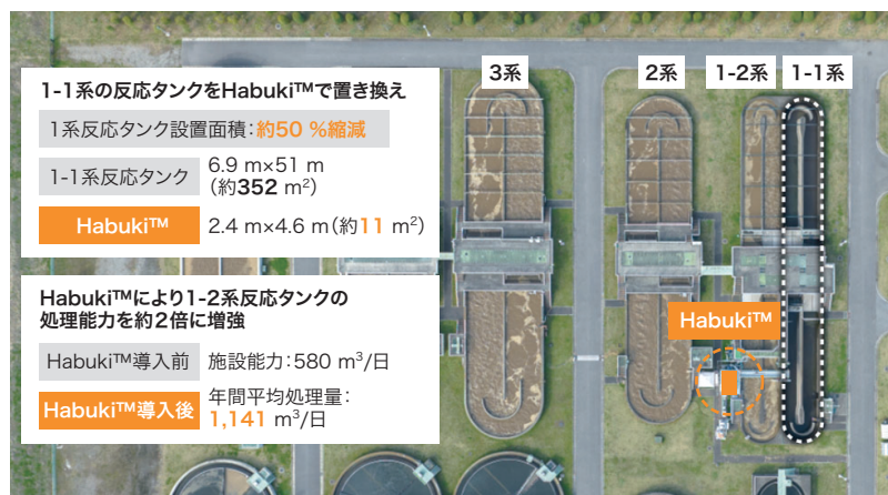
栃木県さくら市 氏家水処理センターでの実規模実証試験 Performance evaluation at Ujiie Sewage Treatment Plant full-scale demonstration facility in Sakura City, Tochigi Prefecture
