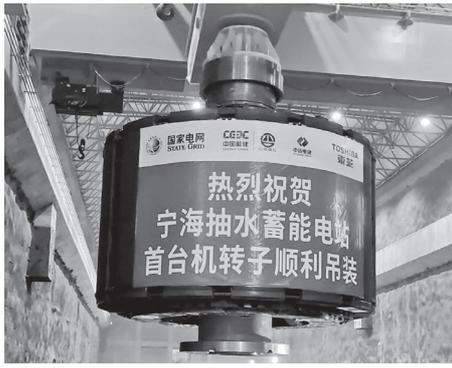
図3. 寧海揚水発電所 発電電動機回転子のつり込み
