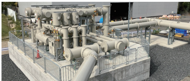
東京電力パワーグリッド（株）北多摩変電所 300 kV GIS 300 kV gas-insulated switchgear (GIS) for TEPCO Power Grid, Inc. Kita-Tama Substation
