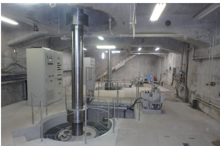
宮崎県企業局 渡川発電所の水車 Hydraulic turbine for Miyazaki Prefecture Enterprise Bureau Dogawa Hydroelectric Power Station
