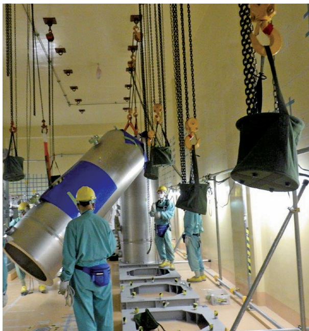
廃ガス貯留設備（工事中） Active vessel off-gas treatment units under construction
