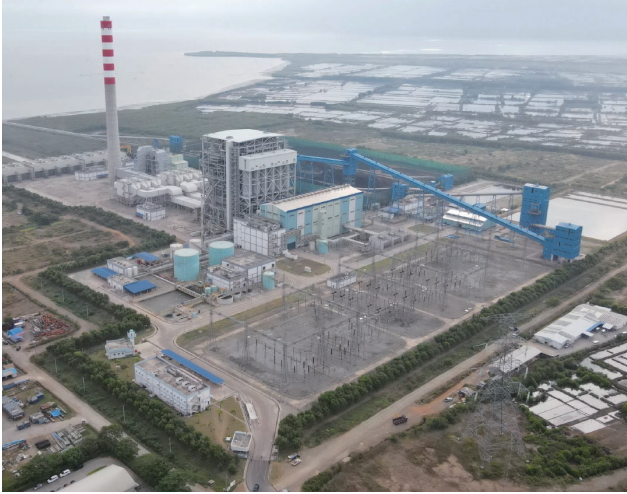
チレボン拡張石炭火力発電所 1 000 MW Cirebon2 coal fired power plant, Indonesia
