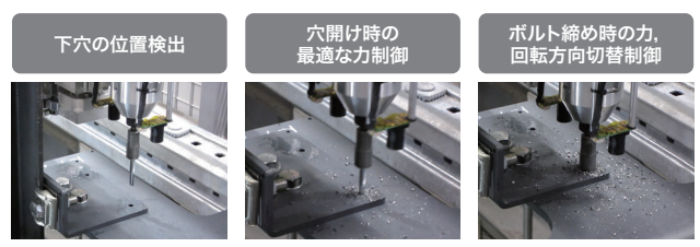
作業者の動作を再現して自動施工したドリルねじ Automatic installation of drill screws (reproducing skills of experts)
