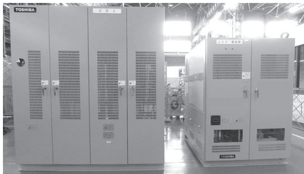
図2. 従来製品(左)とコンパクトシリコン整流器(右)の外観比較
