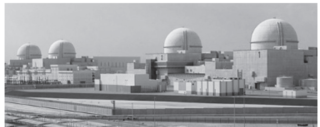
図4. バラカ原子力発電所
