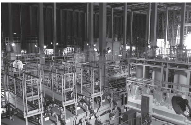
図9. 増設ALPSの全景
