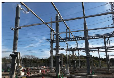
240 kV ポリマーがい管形ガス断路器
