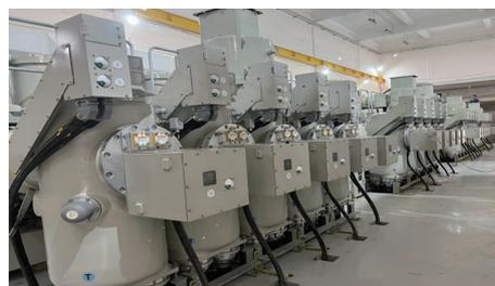
132 kV ガス絶縁開閉装置
