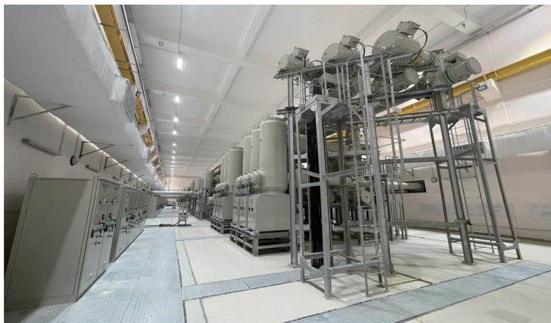
400 kV ガス絶縁開閉装置
