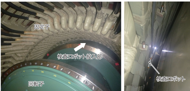
検査ロボットによる詳細検査の様子 Detailed inspection of turbine generator applying inspection robot at Barakah Nuclear Energy Plant Unit 1, United Arab Emirates
