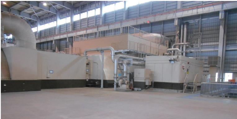
更新後の4号系列第2軸の機器（ガスタービン，燃料弁室）
