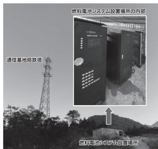
図2. メタノール改質型燃料電池システムが設置された通信基地局
