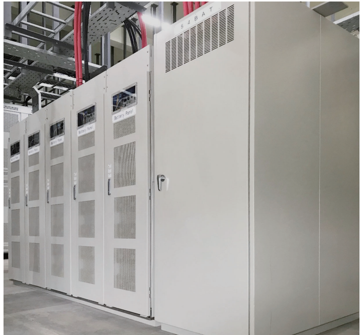
ダッカMRT6号線変電所内に設置されたTESS TESS installed at substation on Dhaka MRT Line 6
