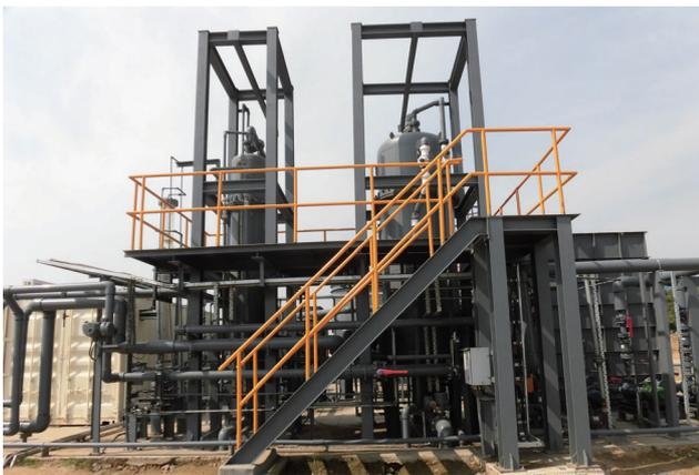
高速ろ過装置の実証試験設備
