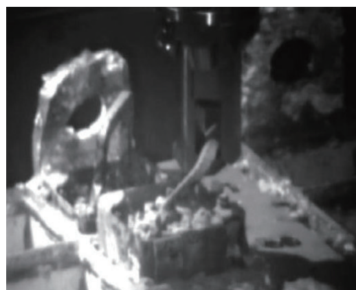
ハンドルが変形した燃料の取り出しの様子 Scene of removal of fuel with deformed handle
