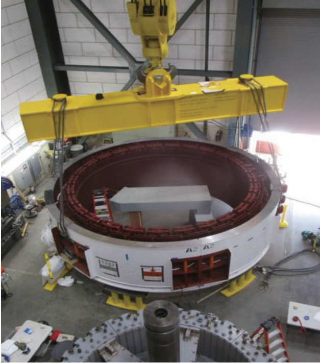
発電機固定子のつり込み
