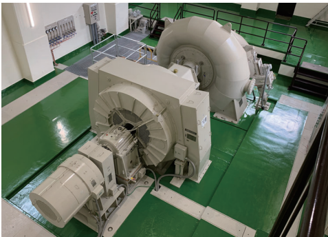
洞戸発電所の水車
