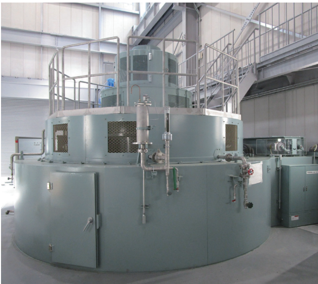
雨畑川発電所の水車発電機
