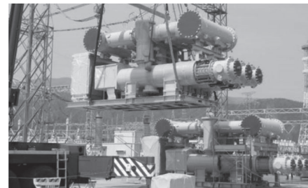
(a) 新形GISの据え付けの様子
