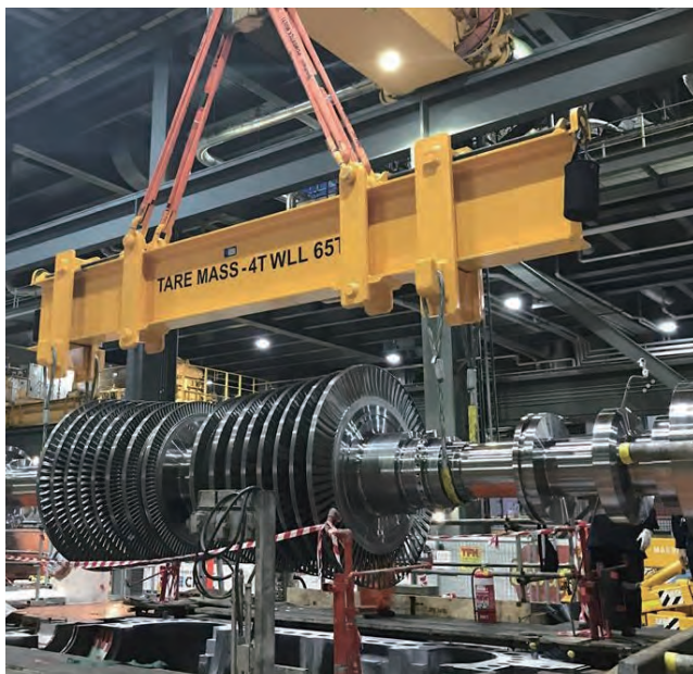
マウントパイパー発電所1号機の中圧ローター据付作業 Installation of intermediate-pressure (IP) rotor at Mt Piper Power Station Unit 1, Australia
