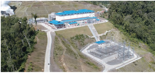
ルムットバライ地熱発電所 1号機 Lumut Balai Geothermal Power Plant Unit 1, Indonesia
