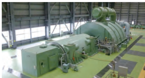
東北電力(株)能代火力発電所3号機の蒸気タービン・発電機 Steam turbine and generator for Noshiro Thermal Power Station Unit 3 of Tohoku Electric Power Co., Inc.
