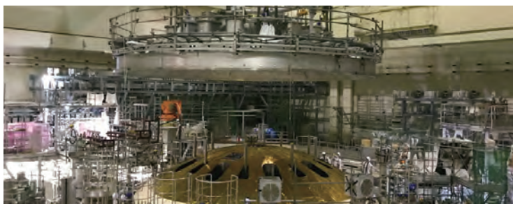
クライオスタット上蓋の据え付け
