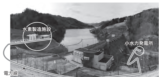
図1. 庶路ダムに設置された実証設備
