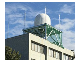
埼玉大学に設置されたMP-PAWRレドーム
