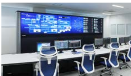
上下水道向け監視制御システム
