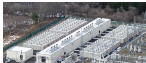
東北電力株式会社様 西仙台変電所系統用蓄電池システム
