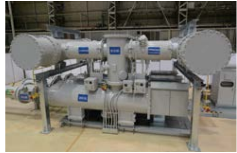
絶縁性能の高いガスを適用して小型化された開閉装置 (GIS)
