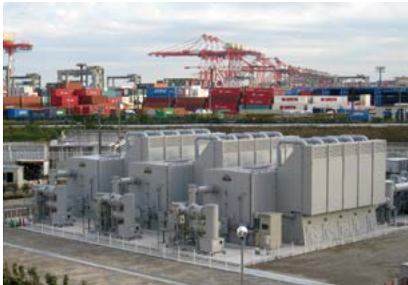
275kV-300MVAガス絶縁変圧器 (東京電力パワーグリッド株式会社 大井ふ頭変電所)
