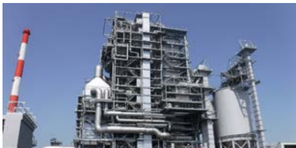
三川発電所(バイオマス)
