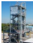
CO 2 分離回収プラント
