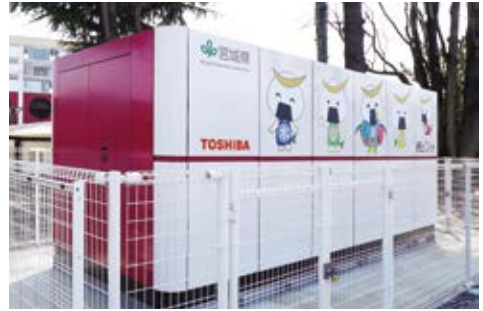
自立型水素エネルギー供給システムH2One™(秦天生命パーク宮城に設置)
