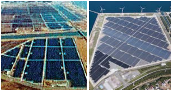
南相馬真野右田海老太陽光発電所
