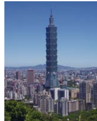
分速1,010mの超高速エレベーターが設置されたTAIPEI101
