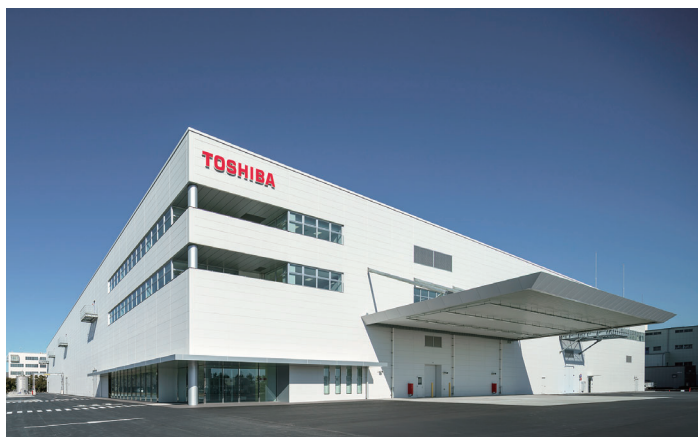
横浜電池工場
