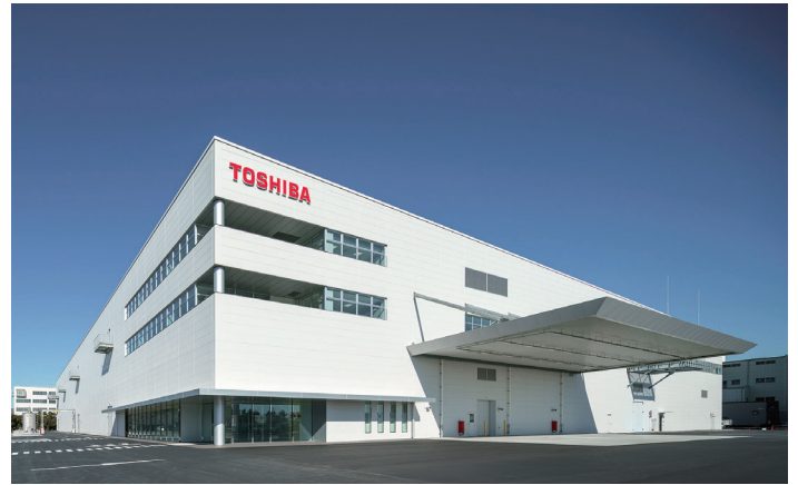
横浜電池工場
