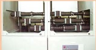
**変流器/接地形計器用変圧器
