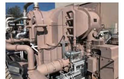
地熱発電用スプレーコンデンサ Spray condenser for geothermal power plant
