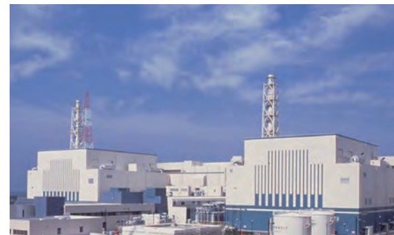
柏崎刈羽原子力発電所 6/7号機 (東京電力ホールディングス株式会社) Kashiwazaki-Kariwa Nuclear Power Station unit No.6 and No.7 (Tokyo Electric Power Company Holdings, Inc.)
