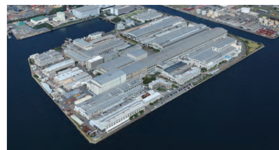
本工場 Main Works
