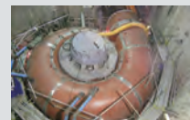
渦巻型ケーシング Spiral casing
