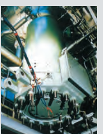
原子炉再循環ポンプ Reactor internal pump
