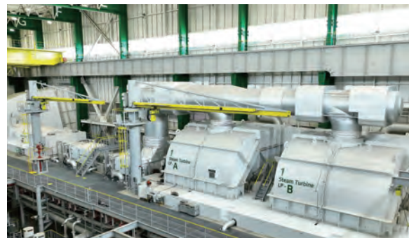
五井火力発電所(五井ユナイテッドジェネレーション合同会社様) Goi Thermal Power Station(Goi United Generation LLC.)
