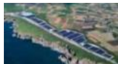
沖縄電力(株) 宮古島メガソーラ 25 x (4kW-8kWh)
