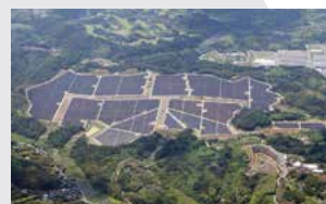
2021 日本No.1 メガソーラー設置シェア
