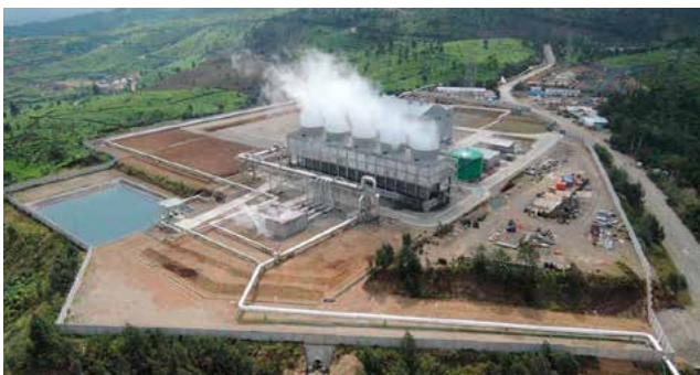
インドネシア パトハ地熱発電所
