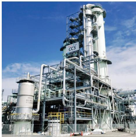
大規模CO<sub>2</sub>分離回収実証設備
