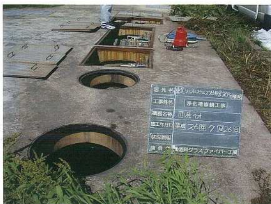
《浄化槽の修繕》
