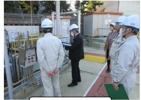
現場審査の様子
