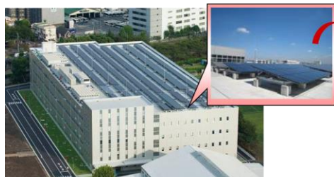
耐震鉄骨上に設置
